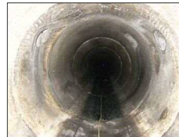
古く老朽化した下水道管
